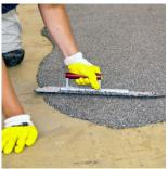
Nun können Sie die Fläche mit der Kelle in wenigen Zügen verdichten und glätten. Achten Sie dabei auf gleichmäßigen Druck und halten Sie das Werkzeug nur leicht angekantet, so dass es fast flach aufliegt und geschmeidig, aber unter Druck, über die Kornspitzen gleitet und die Steinchen gut verpresst.
